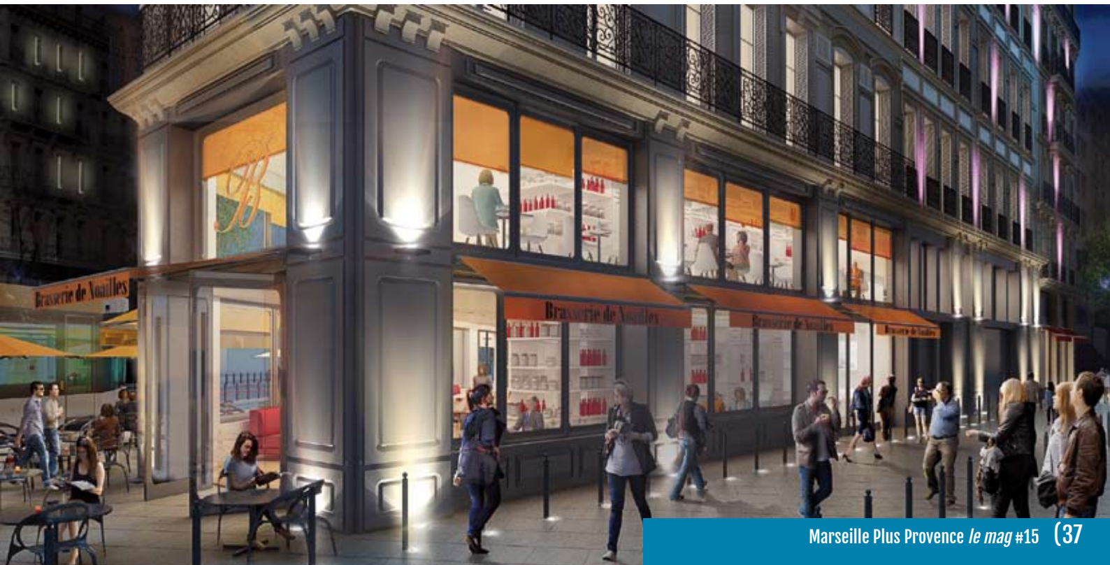
Aujourd'hui, les travaux ont débuté.
